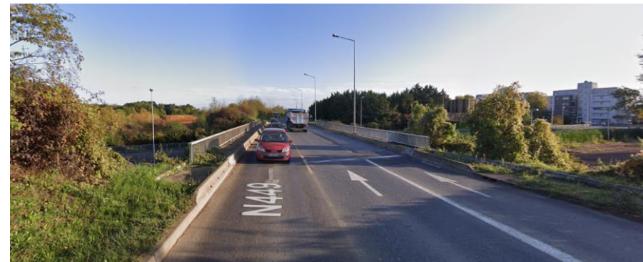
Passage de la N449 au Nord du site – voie traitée en tant qu'autoroute urbaine avec, selon les secteurs, des doubles voies, des terres pleines ou encore des glissières de sécurité, ce qui en fait un motif de très forte fragmentation urbaine – Source : Google Street View
