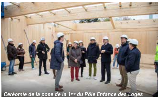
Cérémonie de la pose de la 1 ère du Pôle Enfance des Loges
